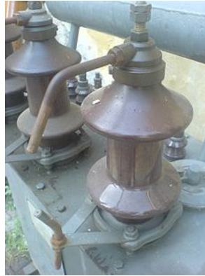
Figura 3.25: Cuernos de arco de un transformador
